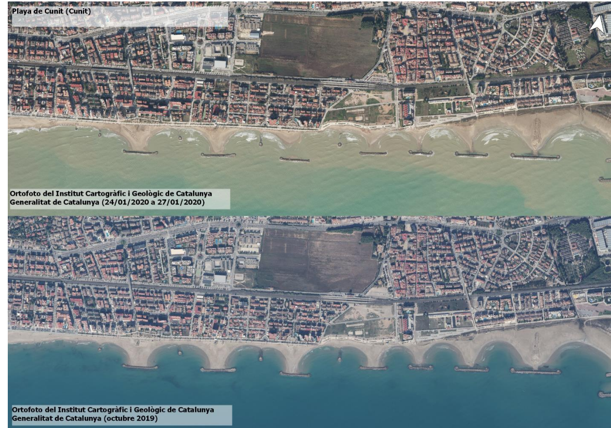
Cunit (Cunit, Tarragona).
