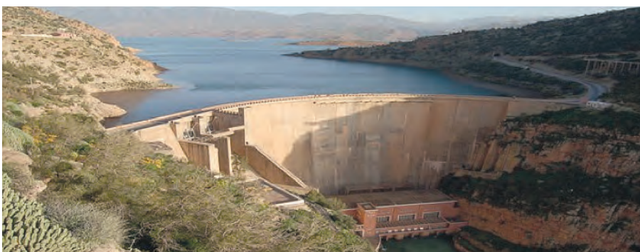
Bin El Ouidane dam
