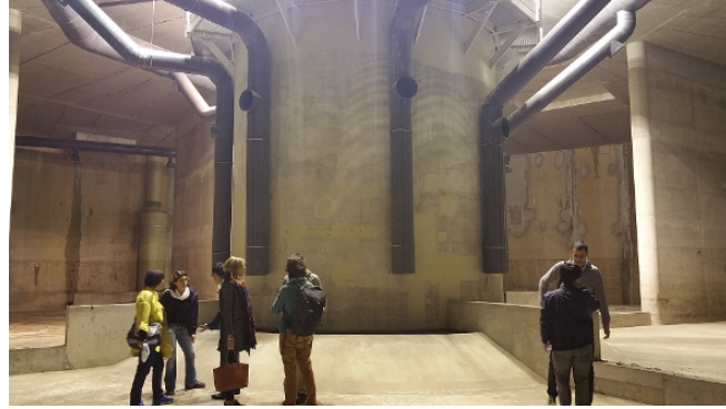
法国马赛中心广场地下蓄水场所 Underground flood storage tank in downtown Marseilles
